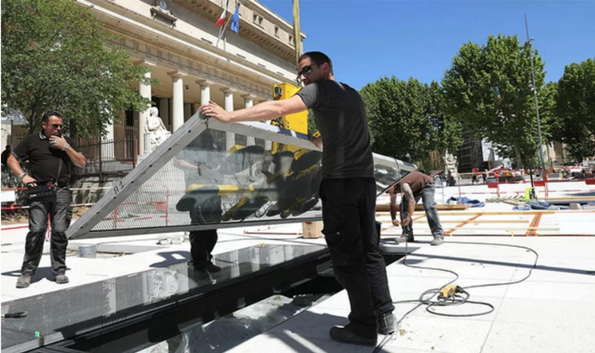
Les vitres qui laisseront entrevoir les vestiges sur environ 60 m<sup>2</sup>, sont suffisamment résistantes pour supporter une charge de 500 kilos par mètre carré.
