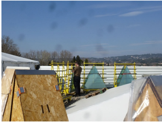
La restauration de la verrière de l'alvéole 04 © J. Repiquet
