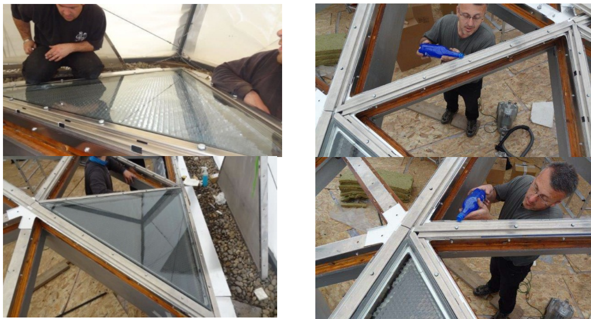
La restauration de la verrière de l'alvéole 04 © Jan Steenbergen –La Serrurerie
